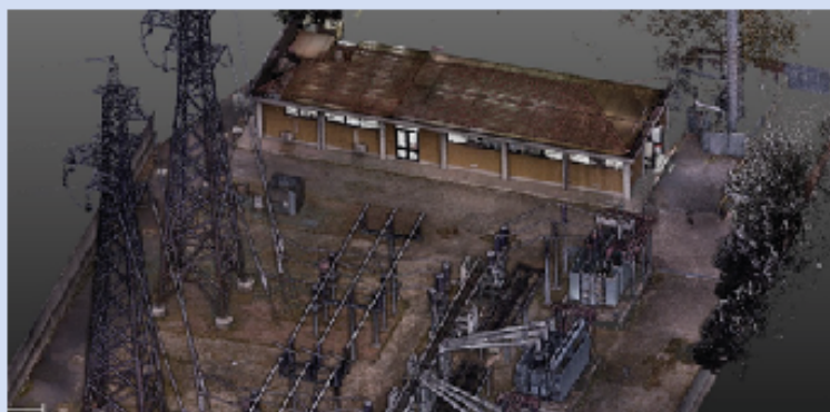
Nuvola di punti con colorazione RGB del sito rilevato (particolare 1)
